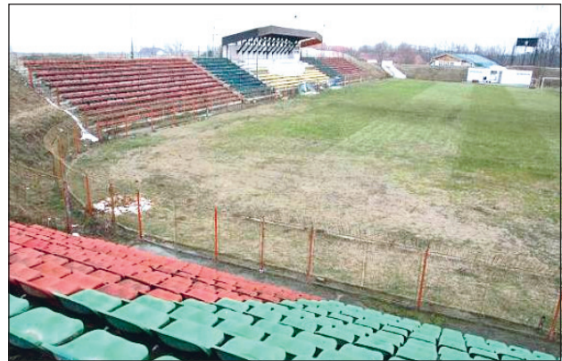
Stadionul Extensiv (Parc Romanescu), Craiova
