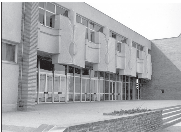
Bazin de înot acoperit, Baia Mare
